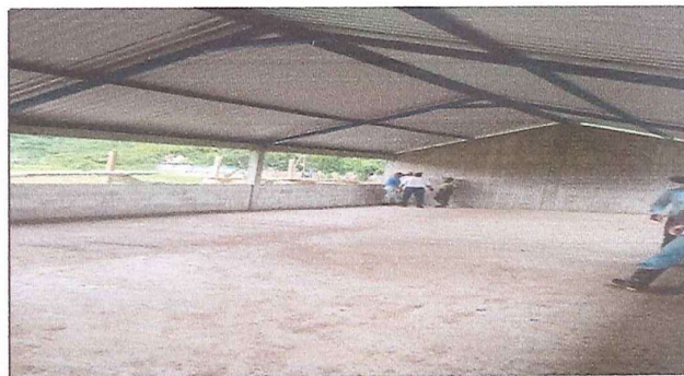
Foto 4: Se observa el piso terminado.
