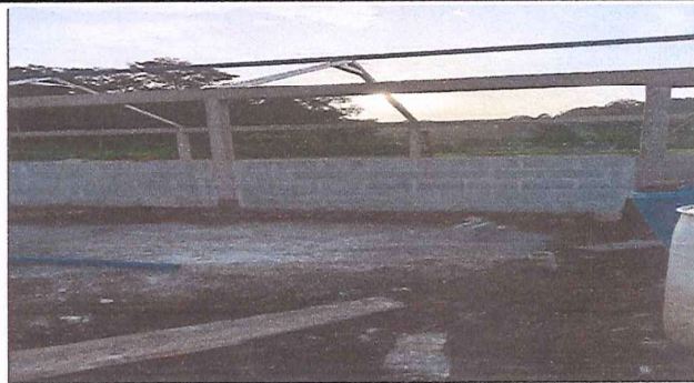
Foto 2: Se observa la colocación del material para el entechado.
