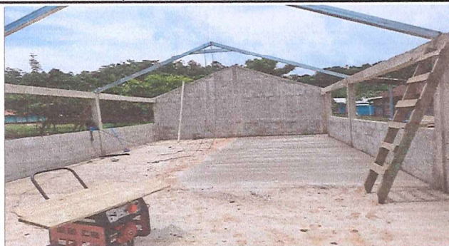
Foto 1: Se observa el trabajo de herrería para cubierta de techo.
