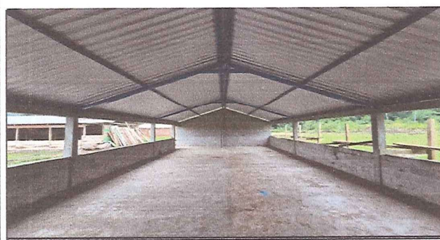
Foto 5: Se observa estructura de techo pintado y terminado.
