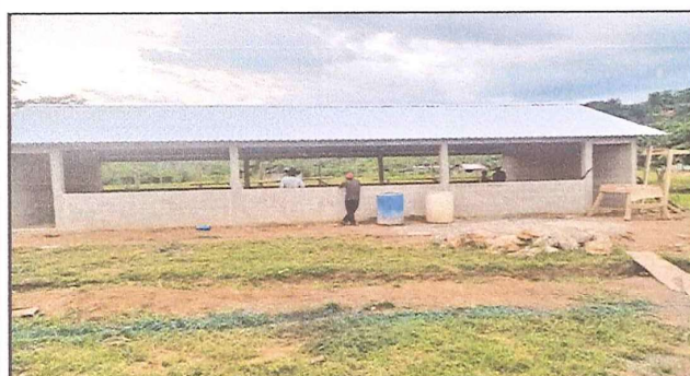
Foto 3: Se observa las láminas ya colocadas.
